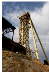
Poço nº 1 com 500m de profundidade. (3)
