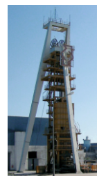
Poço principal, mina de Neves Corvo.
